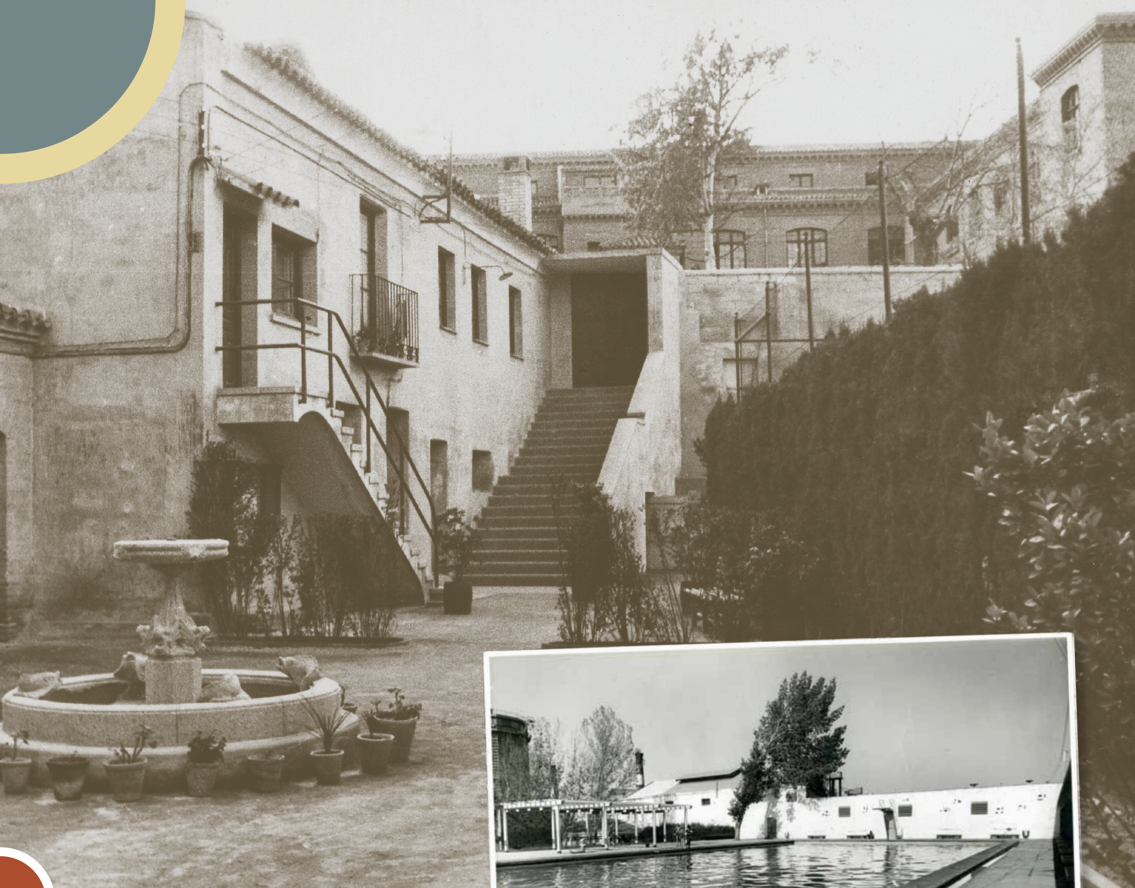
Una vista de las instalaciones del Club en el Paseo de la Mina
